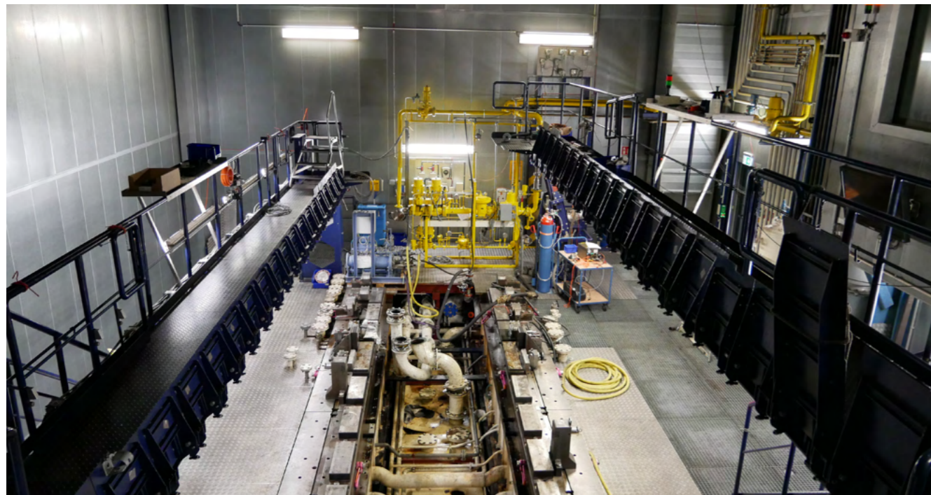
Blick in einen der beiden Großmotorenprüfstände im Anwendungszentrum Wasserstoff
