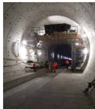
Tunnelröhre mit fahrbarem Gerüst für die manuelle Prüfung.
