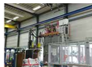
Automatisierte Zustandserfassung mit Hilfe einer Drohne.
